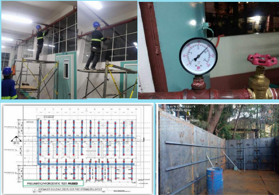
Cistern tank for STP effluent
